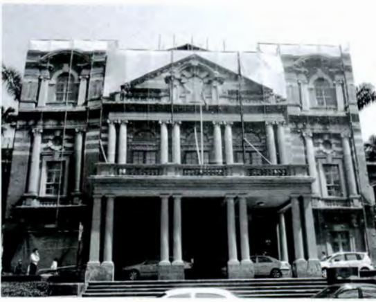
写真 1. NTUH 旧病院. 訪問した際は改修作業中でした.
