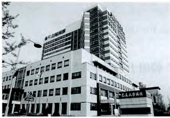
写真 1. Eulji university hospital の外観
