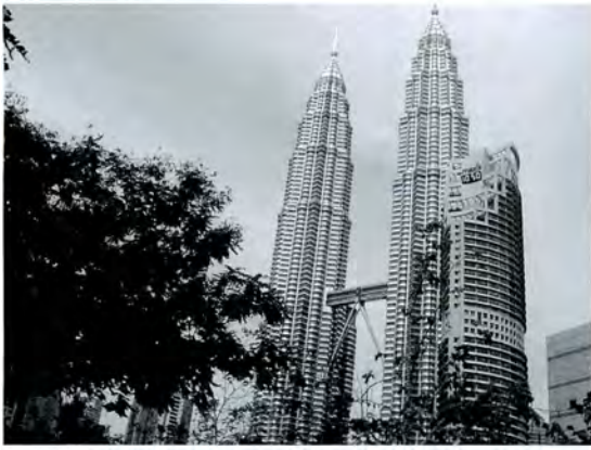
写真 1. クアラルンプールの象徴, PETRONAS Twin Towers
