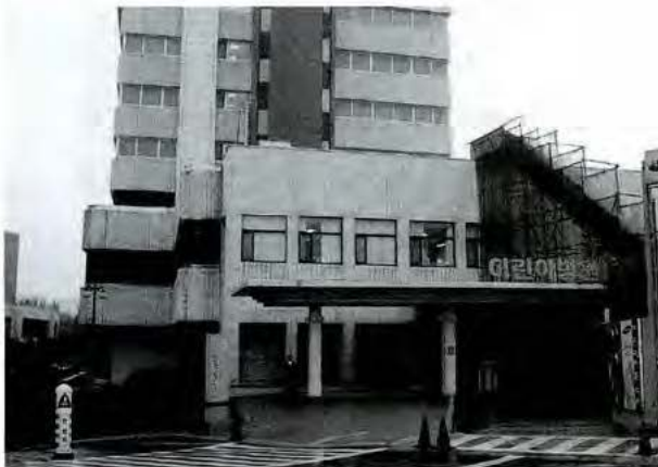
写真 1. Seoul National University Children's Hospital. 現在階層毎に内装工事を進めているとのこと
